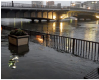
冠水した隅田川テラス（元年10月）
