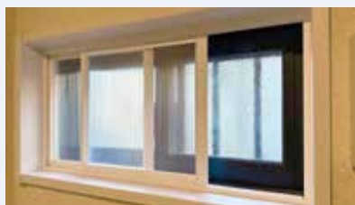
内窓による断熱化
